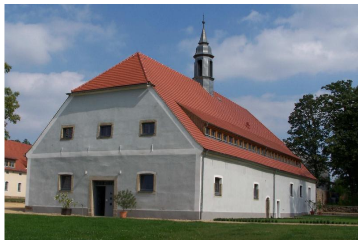
Alte Schmiede - Aussenansicht
