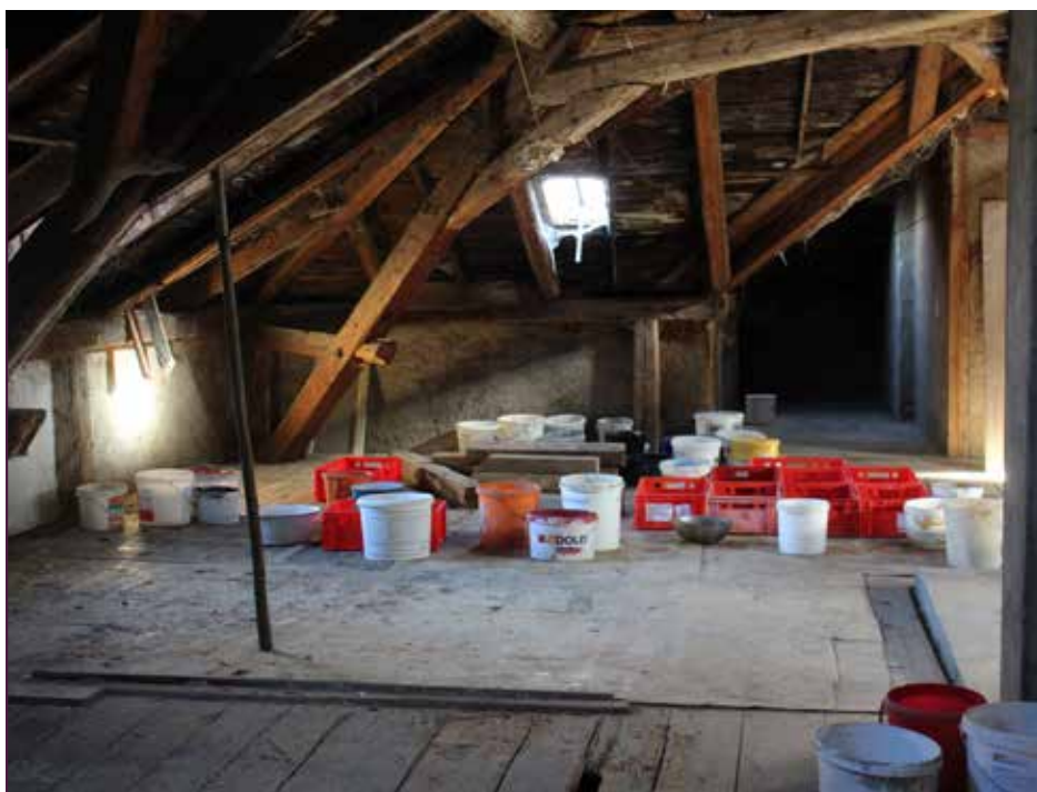
Wenn es regnet, fangen zahlreiche Eimer das Wasser auf, das durch die undichte Dachdeckung tröpfelt
